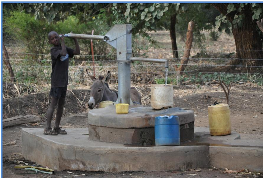
Il tipo di pompa che sarà installata è composta da uno stantuffo ed un pistone che si muovono su e giù in un cilindro chiuso da due valvole.
