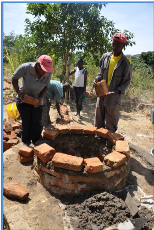
I lavori di scavo del pozzo **Muuo** sono in corso, in una seconda fase interverranno poi gli artigiani che realizzeranno la struttura in mattoni e la copertura in cemento ed installeranno la pompa per il prelievo dell'acqua.
